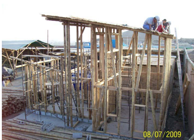
Obra y estado terminado de la Casa de bambú de dos pisos 15
