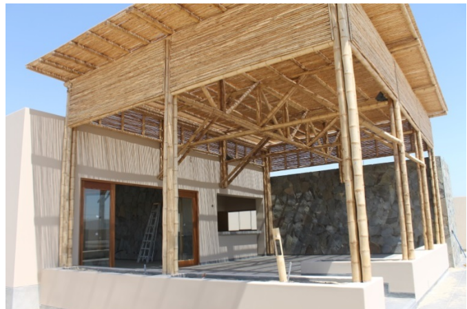
Obra de bambú construida en 2013 por el Maestro Jairo Llamo Hoyos, joven capacitado por el IVUC y CEAS 18
