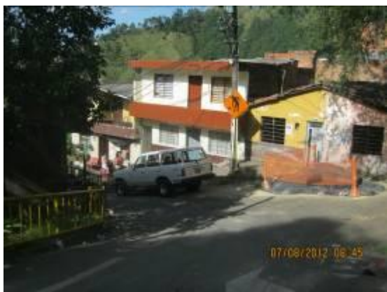
Entrada al barrio La Cascada (Vía al Mar con Carrera 105). A la izquierda una de las viviendas afectada y desocupada
