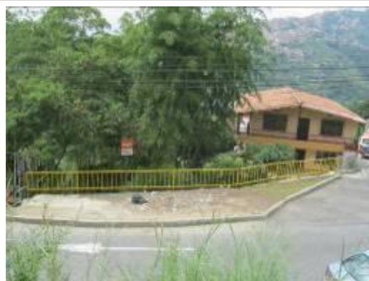
Entrada Paraje El Pinar, Vía al Mar x Cra. 96 A (Calle Los Barrera): Barandas de protección y Obra de Paso Caño La Pajarita
